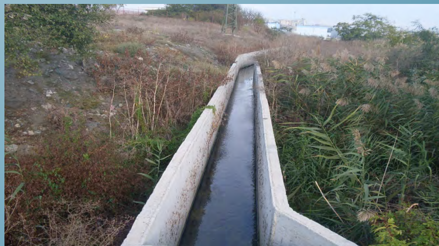
Каналът свързващ пречиствателната станция с езерото
